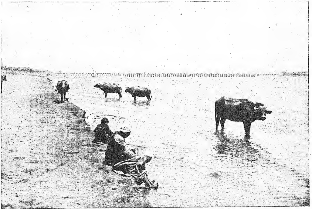
THE ASYÛT DAM
